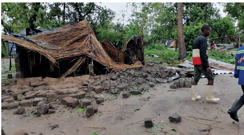
Due immagini dei danni provocati dal ciclone Eloise
